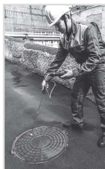
Принудительный забор пробы насосом при обходе трассы подземных газопроводов
