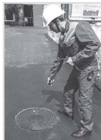
Принудительный забор пробы грушей при обходе трассы подземных газопроводов
